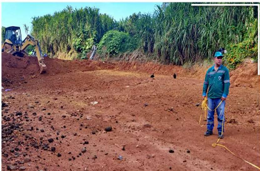
Para la conformación de la primera fase del vaso 2 del relleno sanitario, para la correcta prestación del servicio y la continuidad en la disposición final de los residuos sólidos, se realizó el proceso contractual N° 024 por un valor de 67.235.000 IVA incluido. Donde se realizó la explanación del terreno, removiendo aproximadamente 2223 metros cúbicos de tierra y se realizaron las brechas donde quedarán instalados los filtros de transporte de lixiviados.
